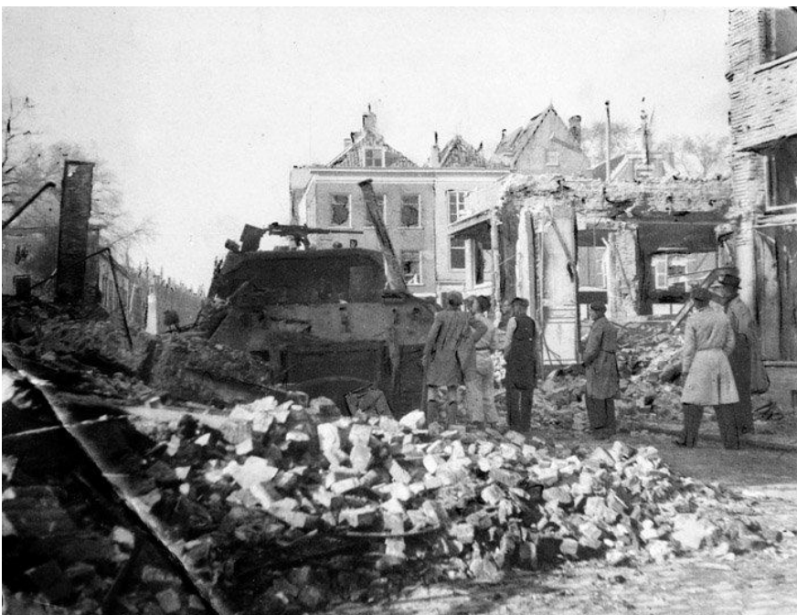
Rechts de uitgebrande boekwinkel op de hoek van de Vischstraat en de Smalle Haven
